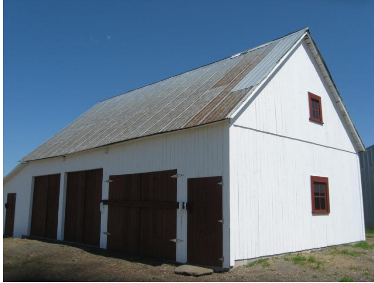
Figure 21. Bâtiment agricole patrimonial restauré
